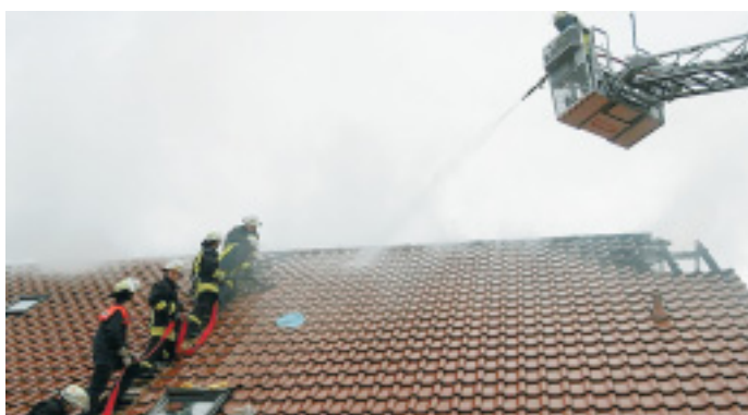
Dichter Qualm: Feuerwehrmänner mit Atemschutz bekämpfen das Feuer unter dem Dachstuhl von zwei Seiten aus. Rechts sind die Tonziegel weggeschmolzen.
